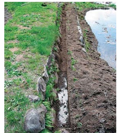
土に埋もれていた水路も復活!!
