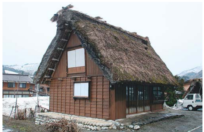
修理後：布基礎を石積みにより修景した
