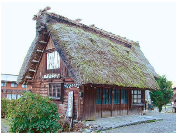
修理前：正面側
